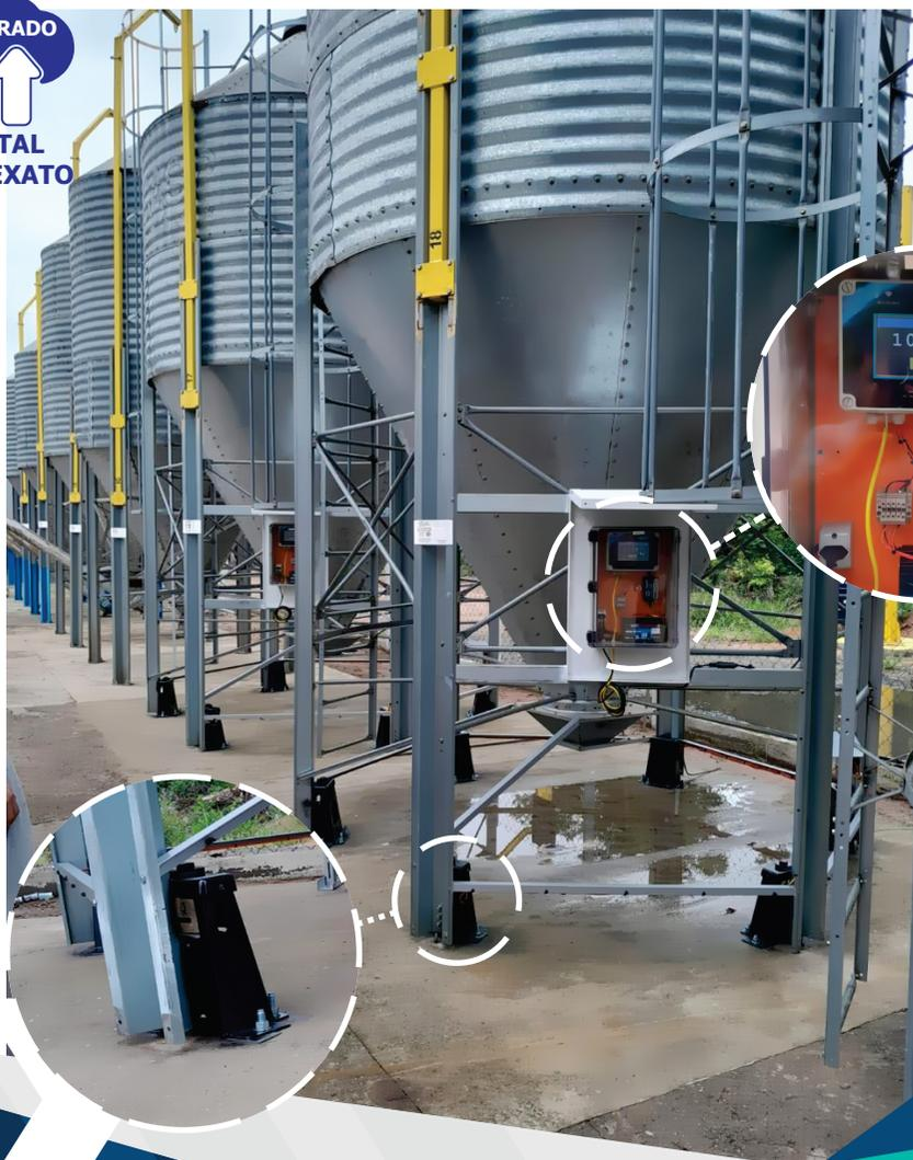
Sistema de Pesaje desarrollado para transformar un silo convencional en una balanza; Cuenta con la precisión de una balanza; Registro de todos los datos de pesaje en tiempo real; Dashboards de datos, informes, ... en el Portal Peso Exato; Puede ser instalado en silos con diferentes números de patas: 3 patas, 4 patas, 6 patas, 8 patas, ...; Capacidad de pesaje dimensionada según la capacidad de almacenamiento del silo (2 t, 5 t, 10 t, 15 t, 20 t, ...);
